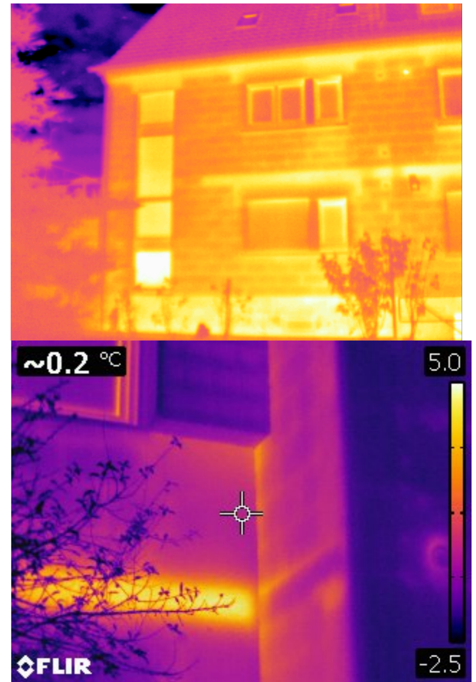
Thermografieaufnahmen haben keinen Bezug zum Beispielhaus und zeigen Schwachstellen anderer Häuser. Quelle: InDiGuD
